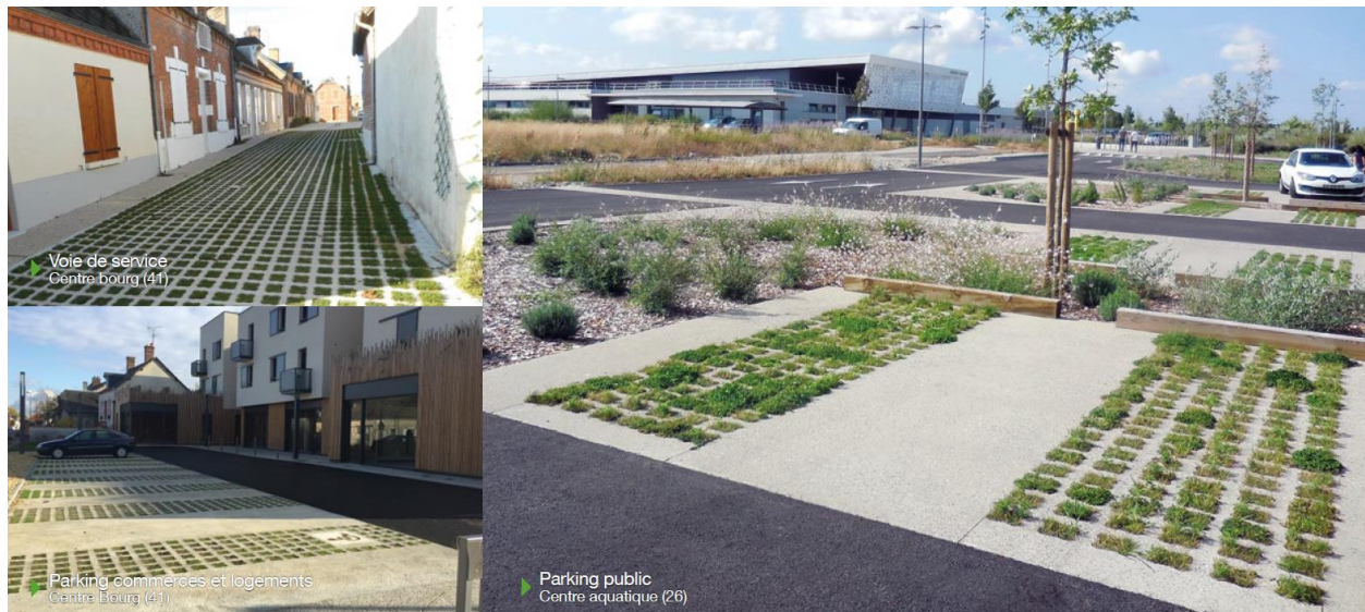
Figure 6 : Exemple d'implantation du type de revêtement projeté (source : Via Verde®)
