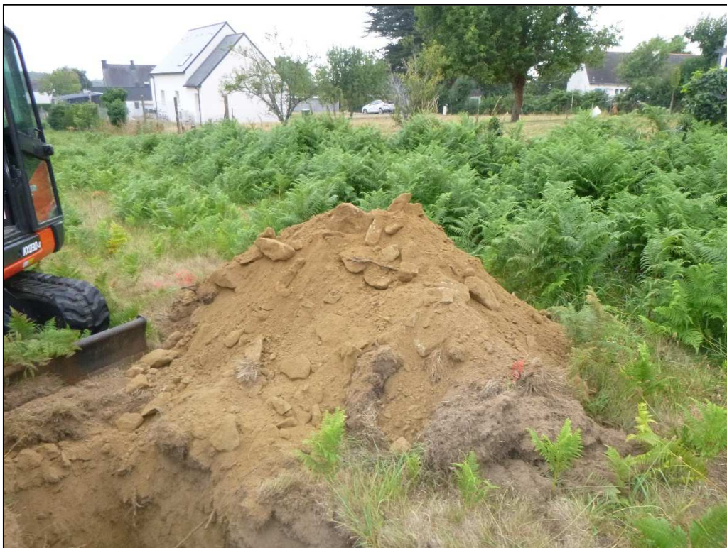
Déblais de F5
