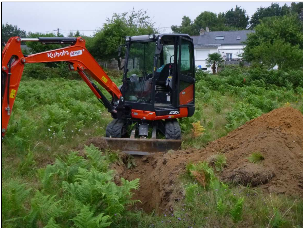
Déblais de F1
