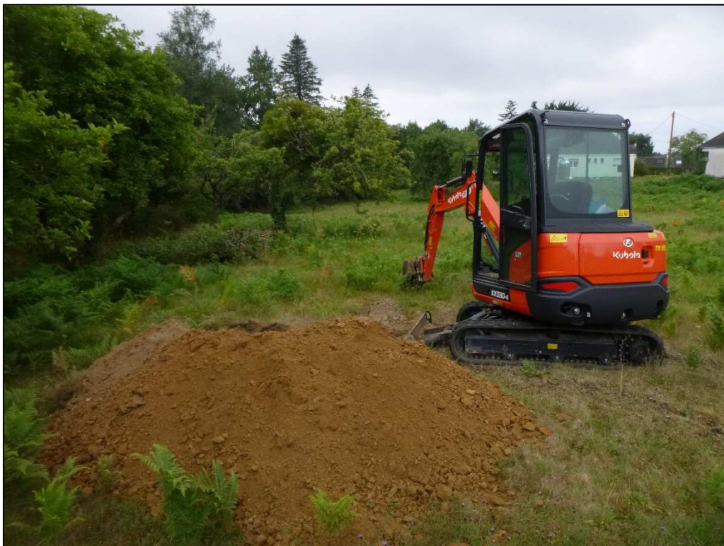
Déblais de F2
