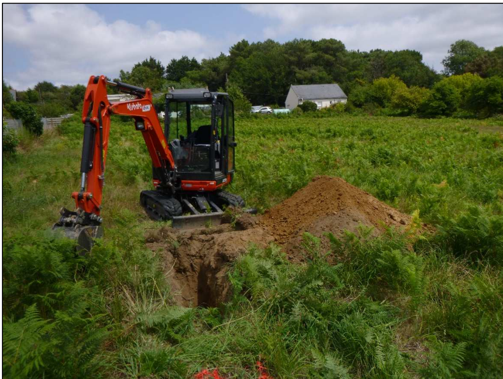
Déblais de F7
